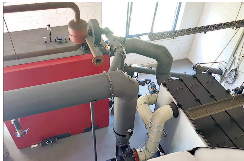
Der Blick von oben verdeutlicht die bauliche Situation.
