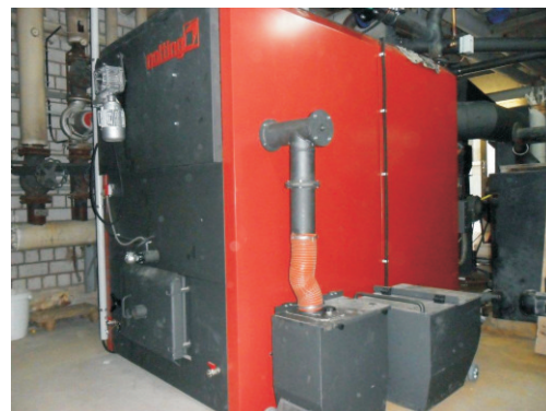
Automatische Vorschubrostfeuerung Typ LCS-RV 400/450
