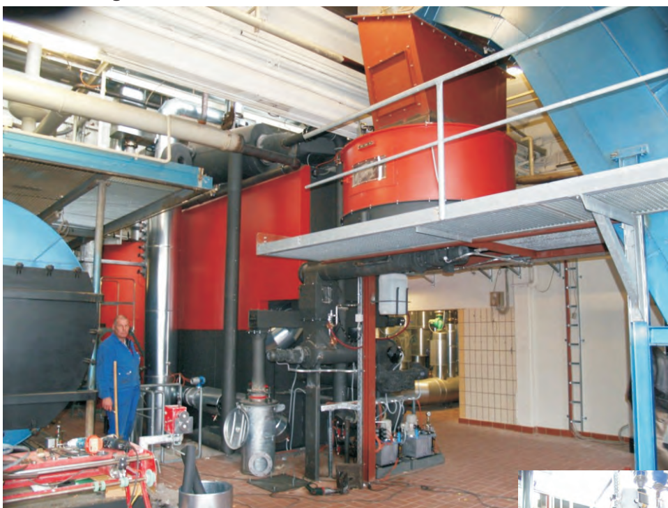
Inbetriebnahme durch Werks- Servicetechniker
