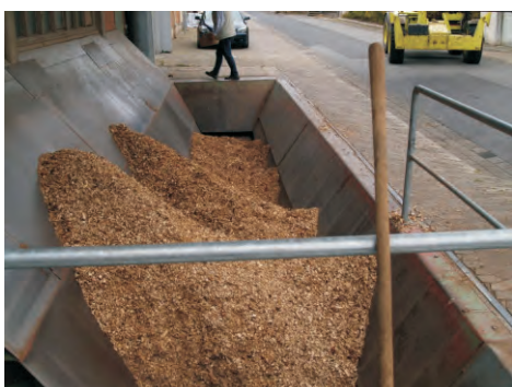
Hackschnitzel G50 / W50 nach Ö-Norm 7133 Hackschnitzellager (unterirdisch mit Deckel)
