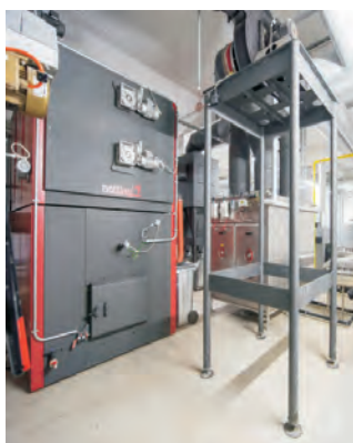
Autom. Vorschubrostfeuerung Typ LCS-RV 875/1050
